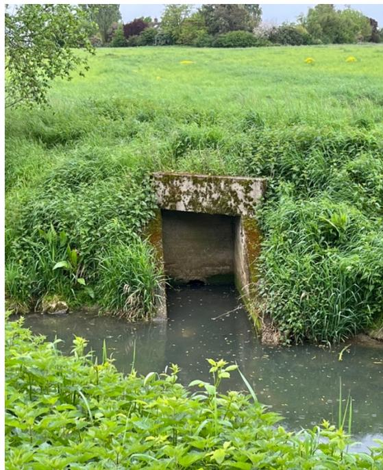
Figure 49 : Photographie d'un exutoire de drain sous le niveau d'eau (Maitre, 2023)
