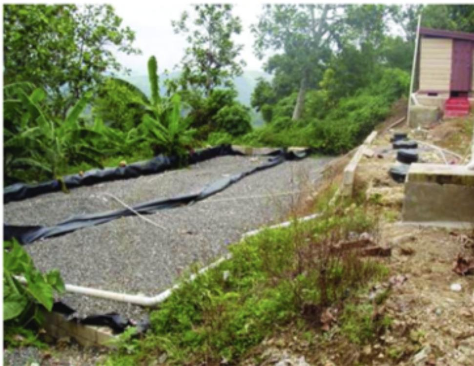
Figure 8 : Photographie d'une ZTHA à flux subsurfacique non végétalisée (Maiga et al., 2017)
