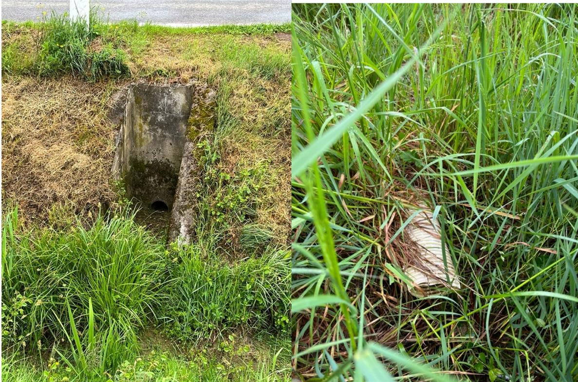
Figure 46 : Photographies (a) d'un exutoire obstrué (b) d'une pose de drain atypique (Maitre, 2023)
