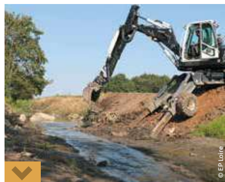
Travaux sur le Dhuy à Vienne-en-Val en 2018
