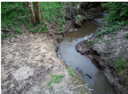
Effondrement de terrain à l'aval du nouveau tracé rectiligne
