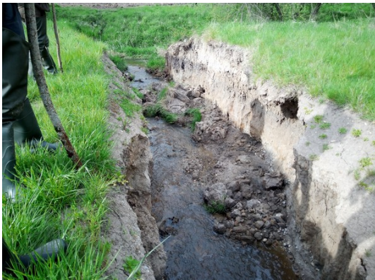
Effondrement de terrain à l'aval du nouveau tracé rectiligne
