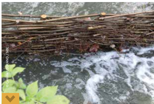
Tressage au niveau de la station d'épuration à Tigy
