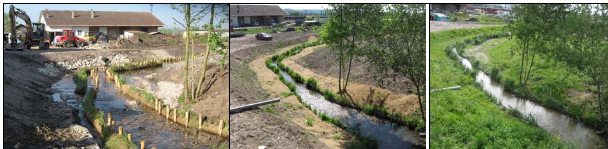
Exemple d'aménagement sur le ruisseau du Clos Pré à Damelevières (54) - source SOGREAH
